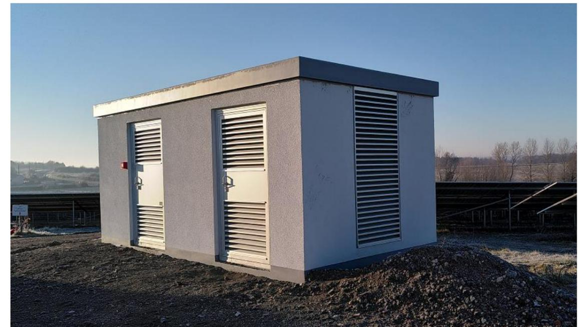
Figure 9 - Poste de transformation remblayé
